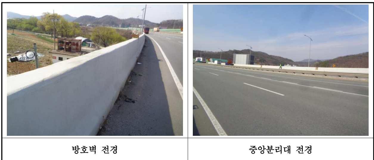
【사진 2.3.21】 난간 및 연석 전경
