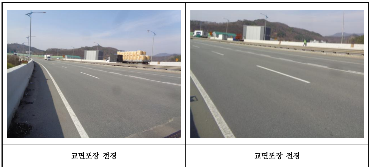
【사진 2.3.17】 교면포장 전경
