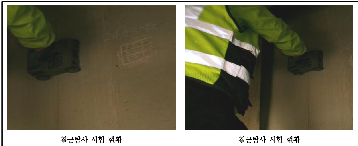
【사진 2.4.2】 철근탐사 시험
