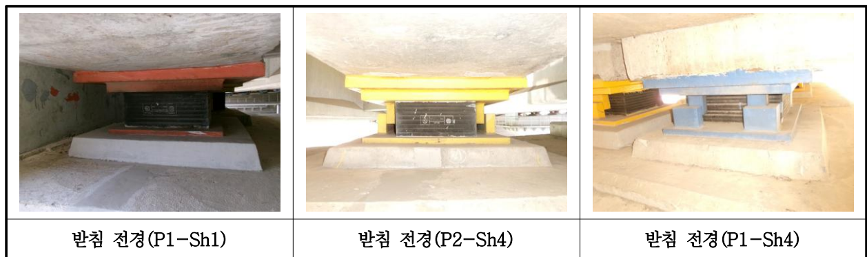
【사진 2.3.12】 교량받침 전경
