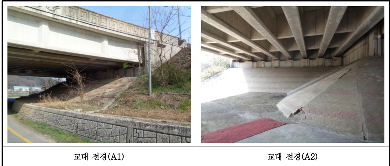
【사진 2.3.8】 교대 전경
